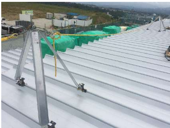
<< 折板屋根用親綱支柱使用例 >>
