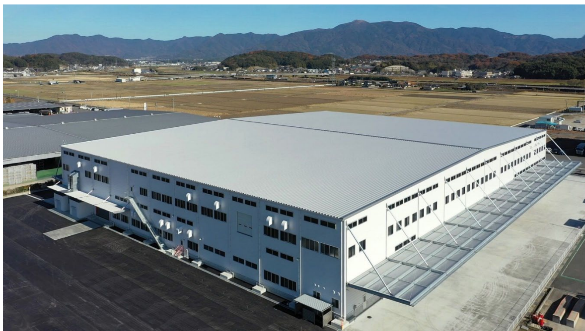
建設地／福岡県鞍手郡小竹町 用途／物流倉庫 商品名／ネオ 階数／2階 施工床面積／20,417㎡
