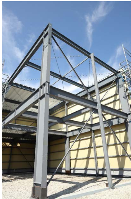
「SUMISYS NEO」 phase II の試作試験状況
