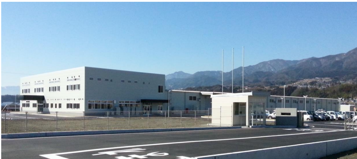
物件名／「横浜ゴム(株)新長野工場」 建設地／長野県下伊那郡 商品／ティオ・トレオ 平屋一部2階／施工床面積6,610㎡ 建築主／横浜ゴム 設計・施工／吉川建設 特記／40m大スパンの機械製作工場
